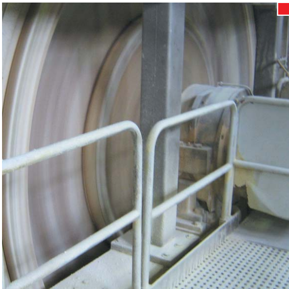
▲ Para los riesgos de atrapamientos las barandillas no impiden el acceso
