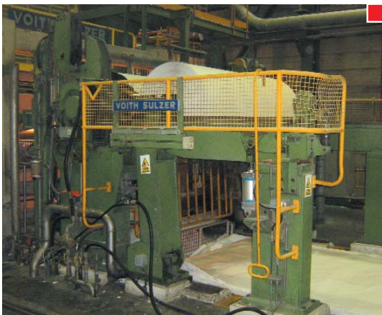
▲ Resguardo en la zona de railes que no impide el acceso por la parte inferior
