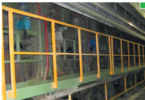
▲ Pasarela lateral con barandilla
