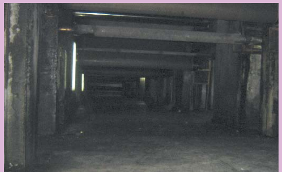
▲ Vista de sótano en batería de secadores
