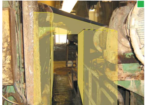
▲ Protección a modo de túnel
