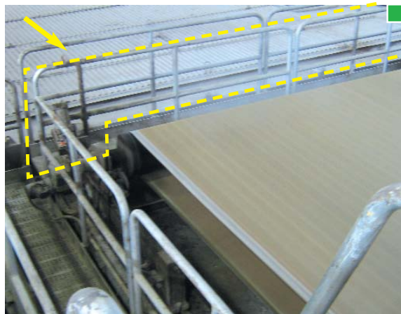
▲ Donde exista pasarela transversal entre campana de sequería y sección de prensas, debe existir barandilla hacia el lado de fieltros
