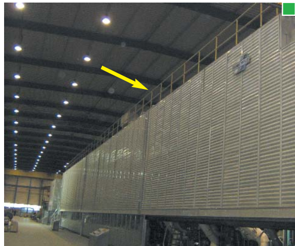
▲ Perímetro protegido mediante barandilla
