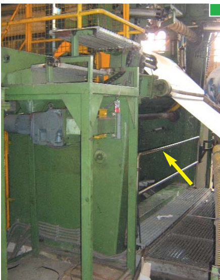
▲ Barandilla en pasarela transversal situada a la entrada de la enrolladora
