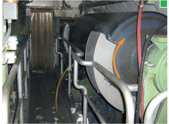
▲ Pasarela transversal con barandillas por ambos lados
