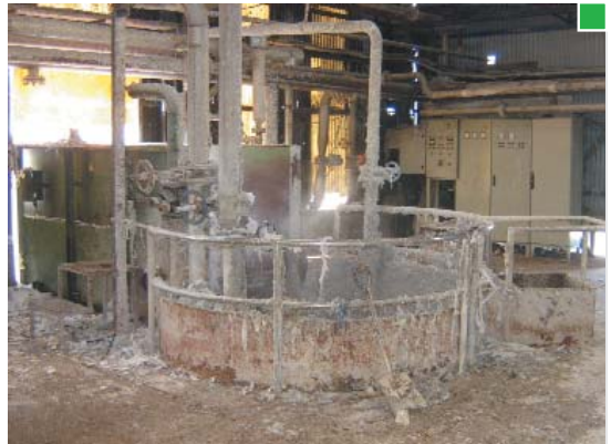
▲ Vista de un púlper con barandilla perimetral
