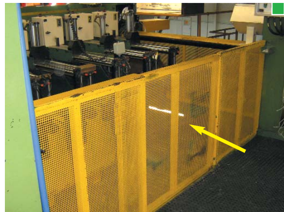
▲ La puerta de acceso debe estar asociada a un dispositivo de enclavamiento y bloqueo para evitar, además, el riesgo de caída en altura
