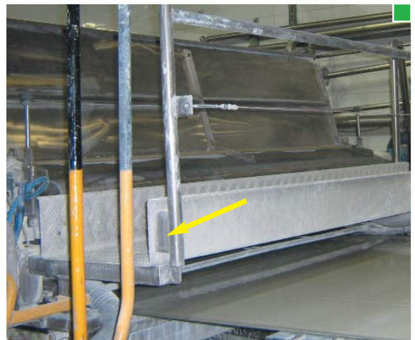
▲ Detalle de rodapié en pasarela transversal
