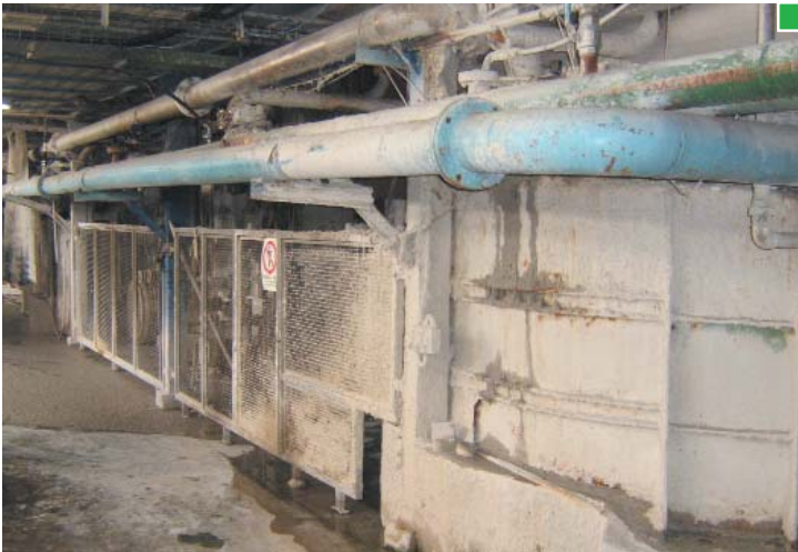
▲ Vallado perimetral en el sótano en zona de prensas
