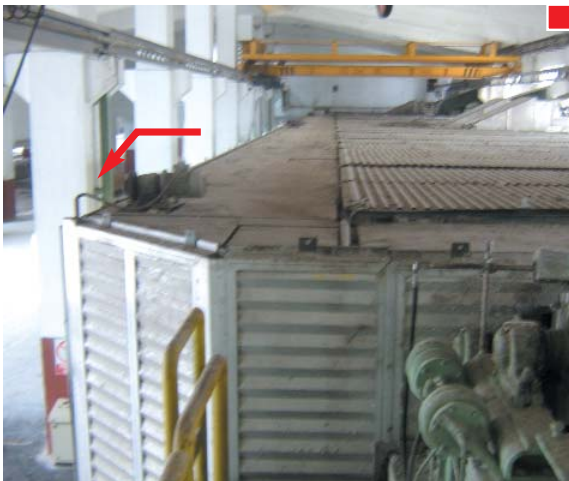
▲ Techo de campana sin protección frente a caídas a distinto nivel
