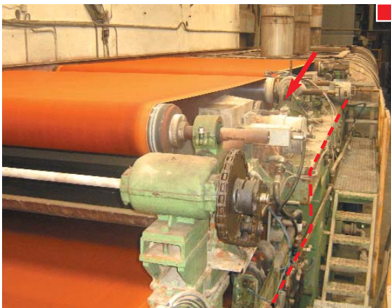
▲ Debe protegerse en las pasarelas mediante barandilla todo riesgo de caída superior a 2 m. Además también debe protegerse el lado interior de la pasarela hacia la máquina
