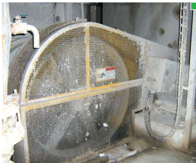
▲ La luz de malla de la rejilla impide alcanzar zonas peligrosas con los miembros superiores. En este caso, para la misma distancia de 80 mm, se ha optado por una rejilla de 6 x 6 mm.
