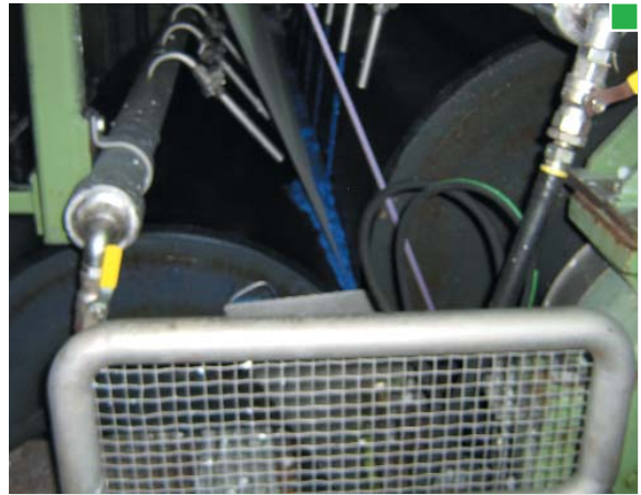
▲ Detalle del resguardo que impide el acceso a la zona de riesgo, por el hueco que deja la estructura de la máquina
