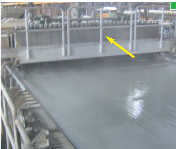
▲ Vista de una pasarela con barandilla
