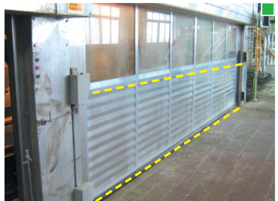
▲ Células fotoeléctricas. En el caso de interferir el haz (línea discontinua amarilla) la puerta se detiene.
