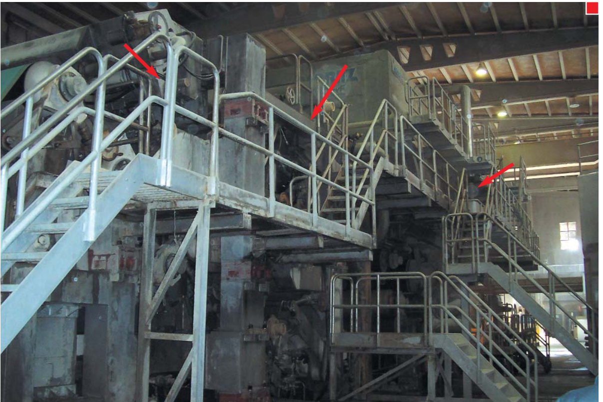
▲ Las escaleras en el lado abierto a plataformas y/o pasarelas deben disponer de puerta de cierre automático.
