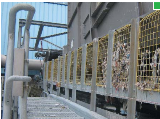
▲ Protección lateral de rodillos locos en cintas transportadoras cuando son accesibles
