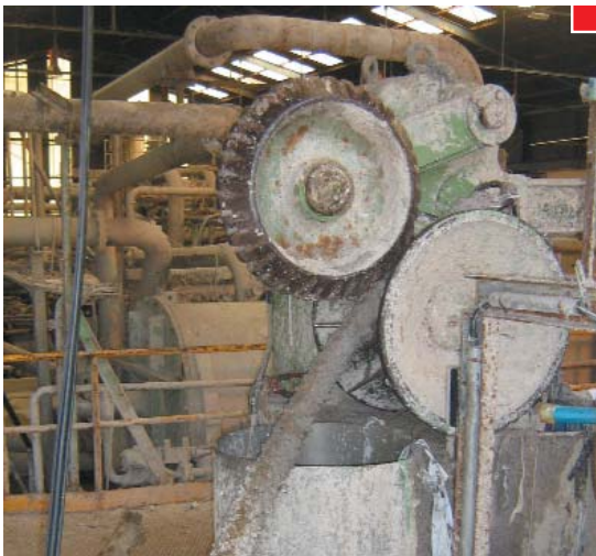
▲ Zona peligrosa en ragger
