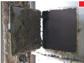
▲ Ventana para inspección visual
