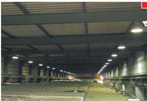
▲ La altura mínima de una barandilla es de 90 cm. En ocasiones no es posible instalarla por ser menor el espacio libre entre el techo de la campana y el puente grúa
