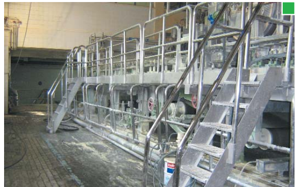
▲ Ejemplo de protección de la zona inferior de la mesa respecto al peligro de caídas al foso o tela. ▲ En este caso, el guardacuerpos, cuelga de la pasarela superior
