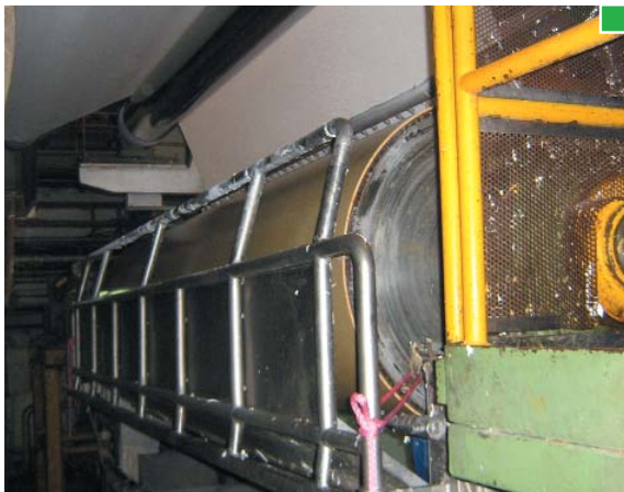
▲ Protección contra el riesgo de arrastre del rodillo hacia el nip
