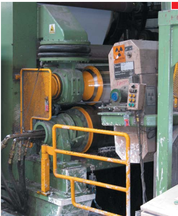
▲ Hueco inadecuadamente protegido con barandilla giratoria
