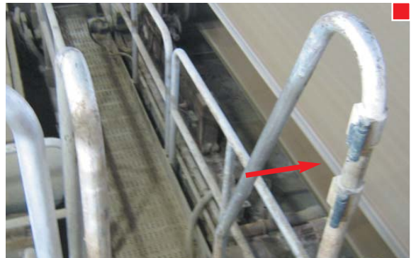
▲ Puerta retirada en una escalera
