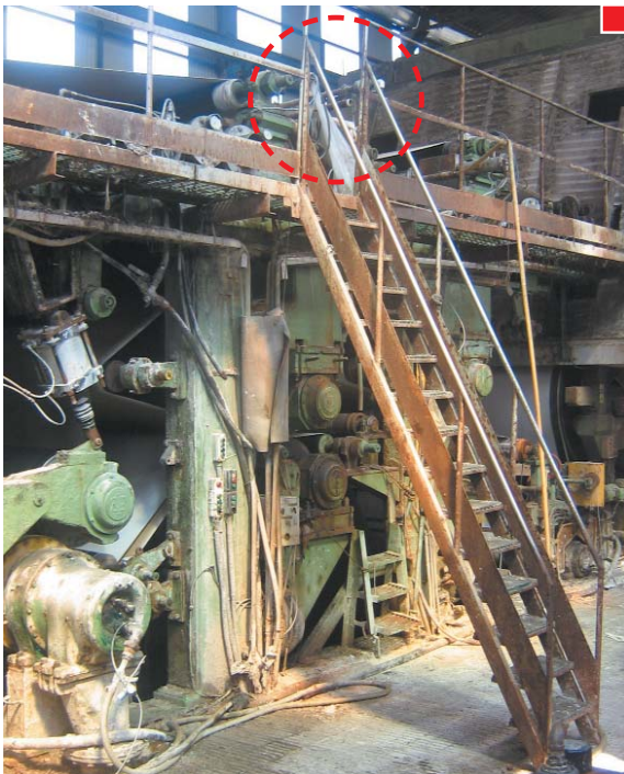
▲ Vista de escalera de acceso a pasarela superior en sección de prensas
