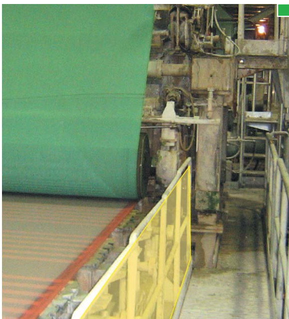
▲ Opción 1. Si existe barandilla, instalar resguardo con rejilla, que impida el alcance de la zona entre las barras
