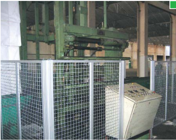
▲ Ejemplo de vallado perimetral fijo
