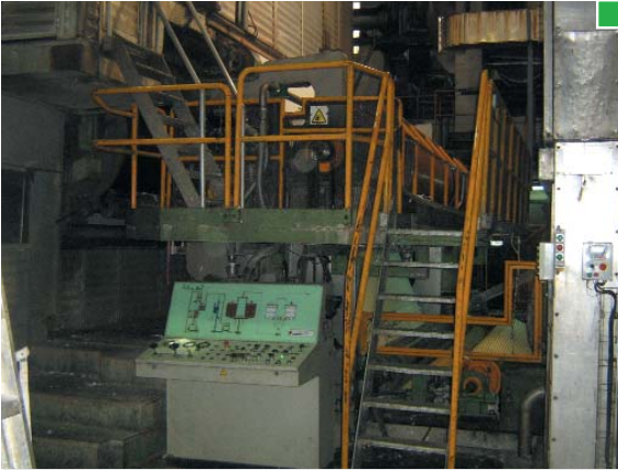
▲ Vista general de medios de acceso a prensa encoladora
