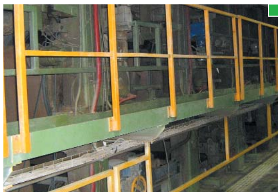
▲ Protección, en zona inferior, equivalente a barandilla
