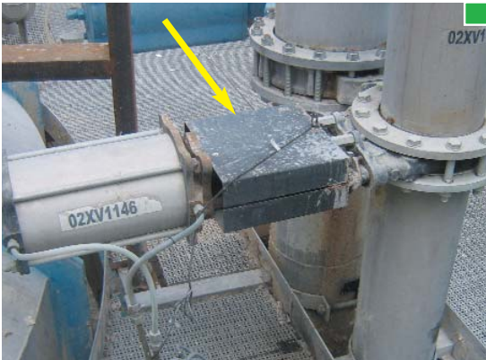
▲ Ejemplo de resguardo en válvula de guillotina o tajadera de accionamiento no manual (eléctrico, neumático, hidráulico) ▲
